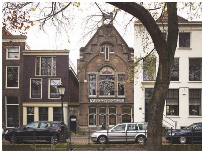
Gevel voorhuis, oude Nicolaikerkerk
